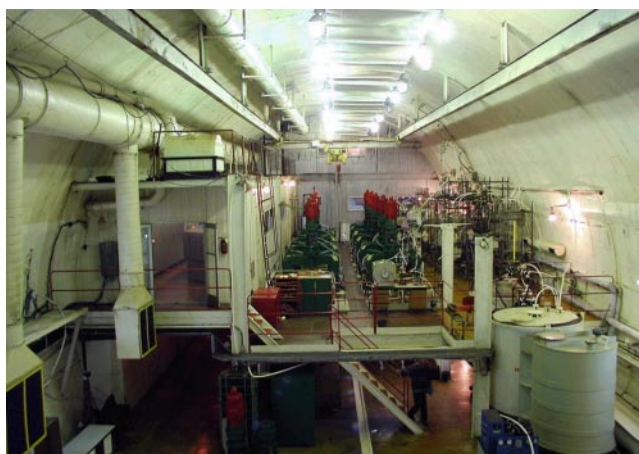
Рис. 4. Общий вид реакторного зала ГГНТ.
